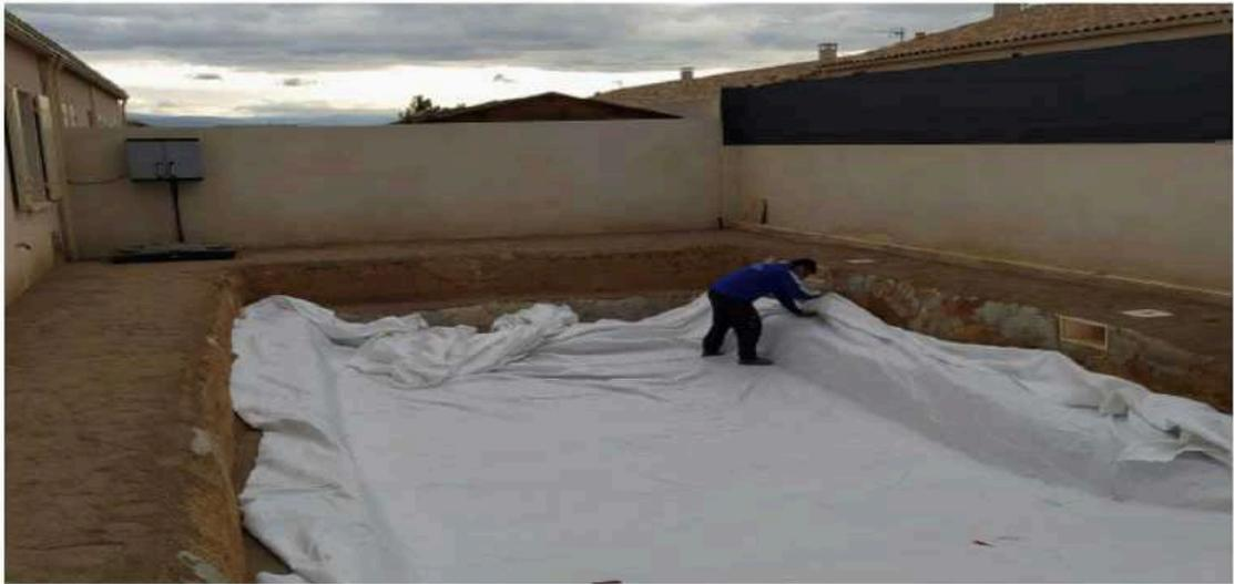
fixation du géotextile au sol et sur les parois avec des agraffes de paillage de jardinier longue de 15 cm sur 2 cm
