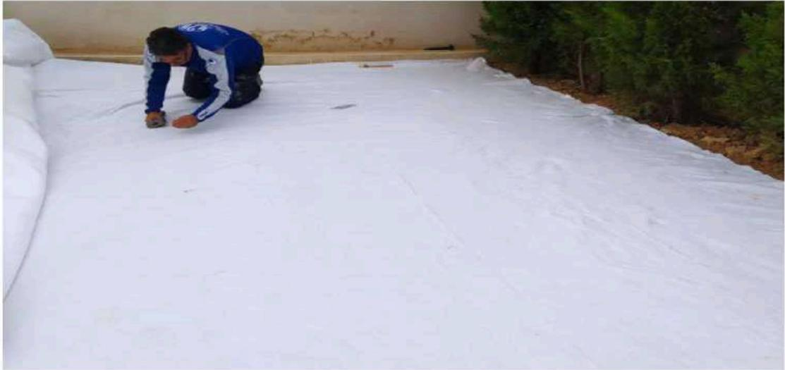
fixer le géotextile avec du mastic à appliquer sur le pourtour des skimmers et des traversées de parois en faisant un joint, puis coller le géotextile dessus
